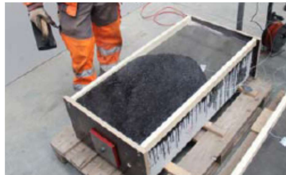
Abb. 7: Einbau des Gussasphaltes [1]
