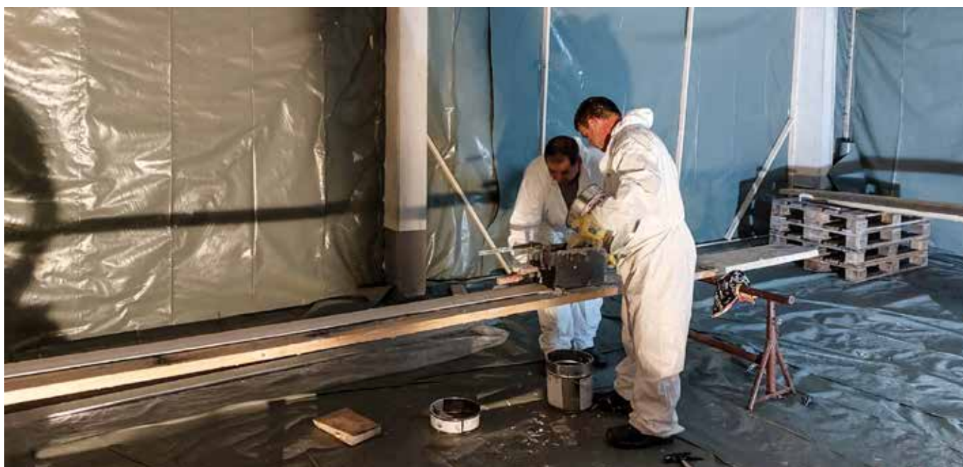
▲ Impressionen von der Installation der CFK-Lamellen.
