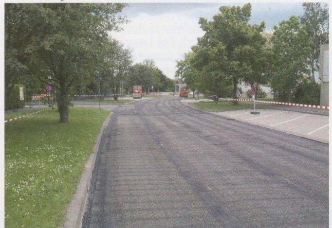
Bild 4. Verlegtes S&P Glasphalt G
