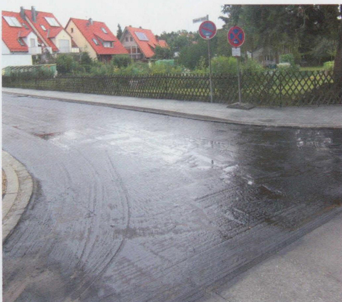
Bild 2. Anspritzen der Bitumenemulsion
