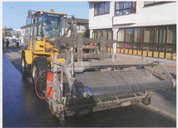
Bild 3. Verlegung von S&P Glasphalt G
