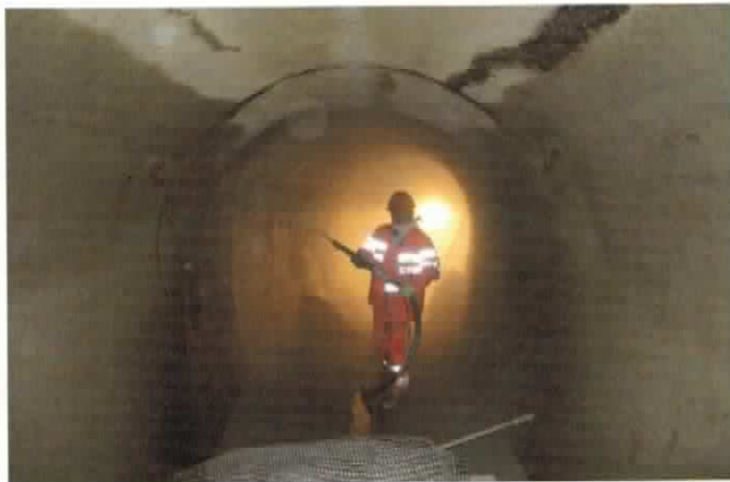
Bild 7. Statische Verstärkung eines Kraftwerkstollens
