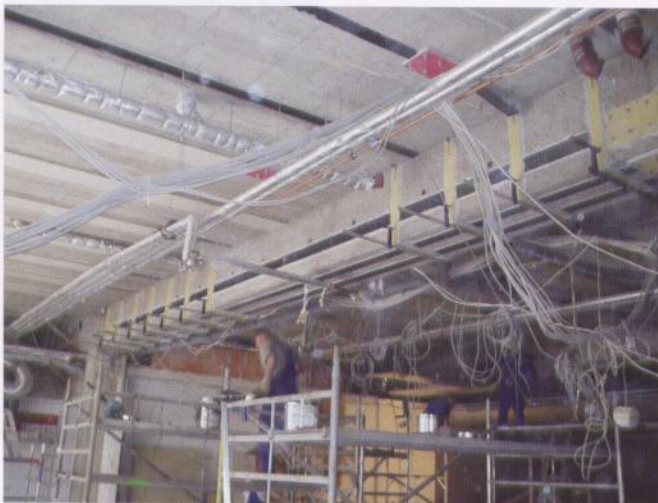
Bild 4. Verstärkung einer Decke mit extern vorgespannten CFK-Lamellen
