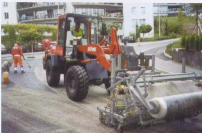
Bild 9. Verlegung vorbituminierter Armierungsgitter im Straßenbau
