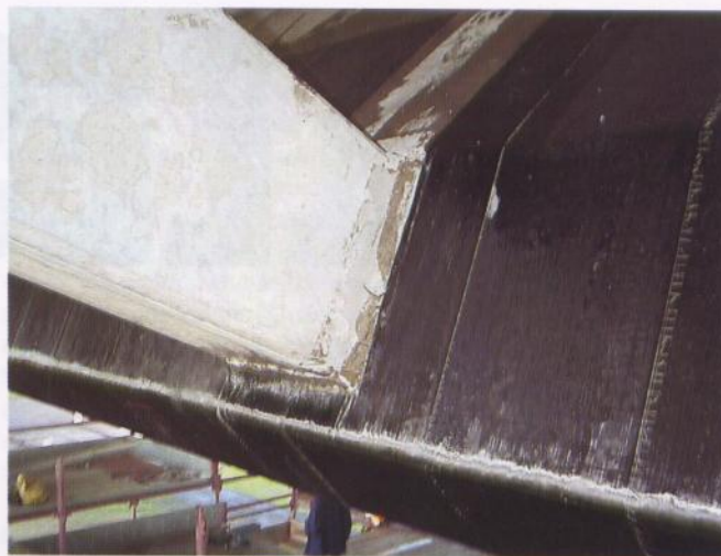
Bild 6 a, b. Querkraft- und Torsionsverstärkung der West Gate Bridge, Melbourne
