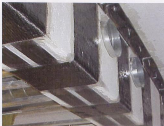
Bild 5. Querkraftverstärkung eines Unterzuges im Hochbau
