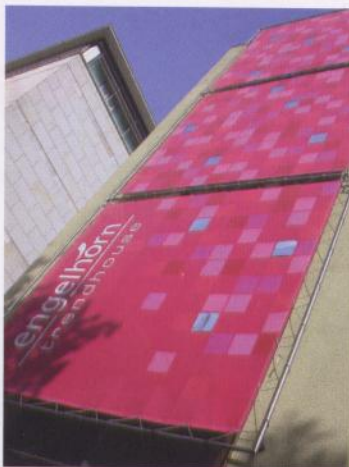
Bild 1. Das Modehaus engelhorn trendhouse in Mannheim: Der völlig neue Geschoslaufbau erforderte eine Verstärkung der Decken
