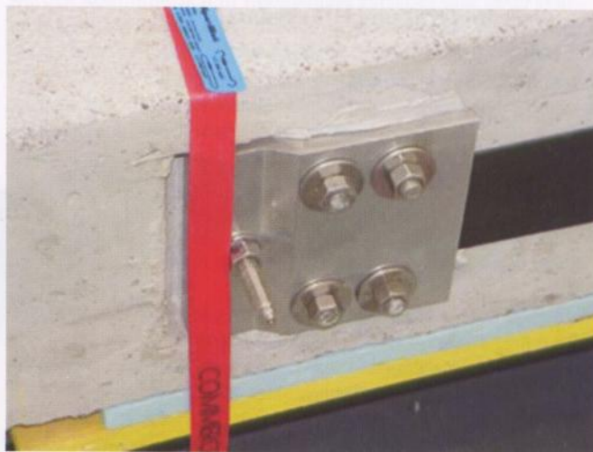
Bild 3. CFK-Lamellen mit mechanischer Endverankerung
