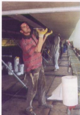
Bild 1. CFK-Lamellen für die Biegezugverstärkung
