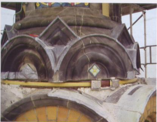
Bild 8 a, b. Umschnürung eines Brückenpfeilers und einer Kuppel mit vorgespannten S&P Aramidbändern
