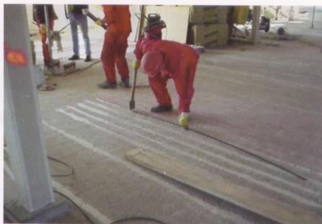
Bild 2. In Schlitze eingeklebte CFK-Lamellen
