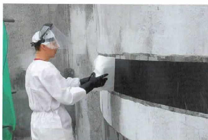
Bild 2 Kohlefaserverbundmatten, wie Sto S&P C Sheets, für eine externe Verstärkung bei Schubbelastung.
