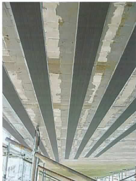
Bild 1 Ertüchtigung einer Brücke durch oberflächlich geklebte Sto S&P CFK Lamellen
