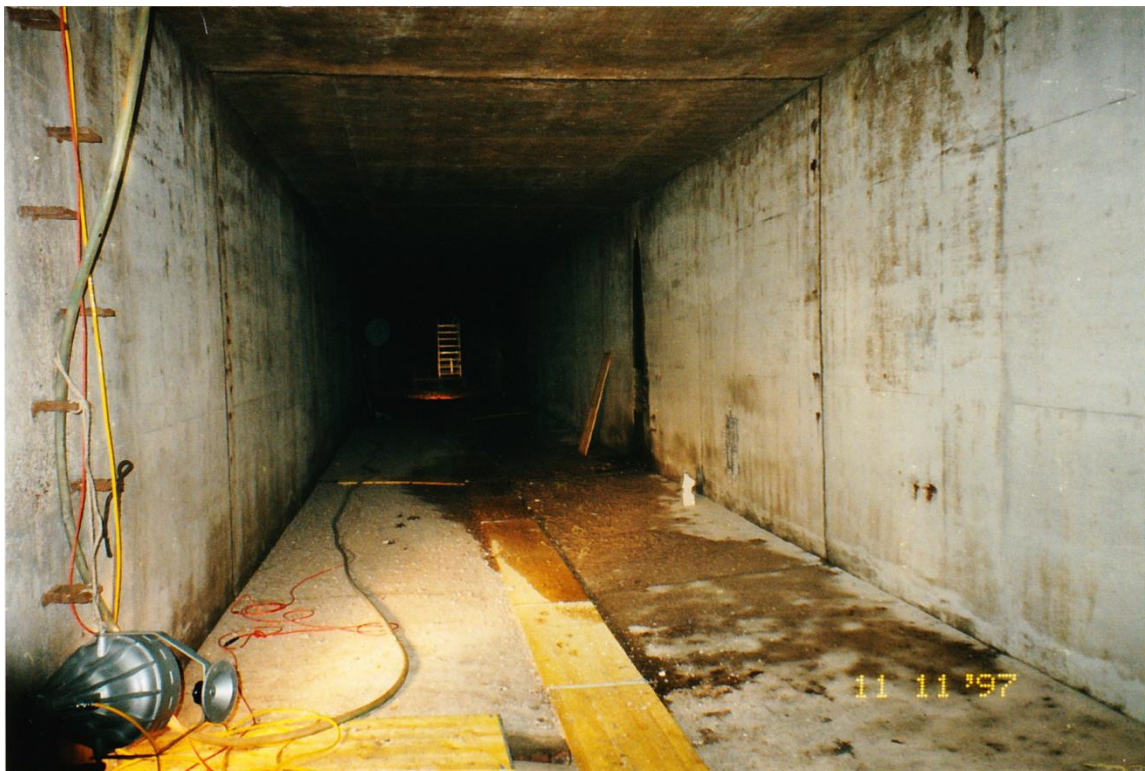
Bild 1: Foto zur Situation vor dem Einbau der CFK-Lamellen (Fa. Wiedemann)
