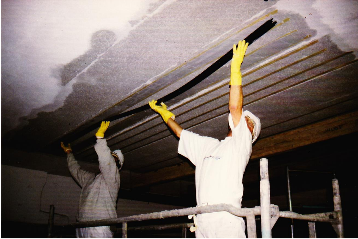
Bild 3: Einbau der CFK-Lamellen durch Mitarbeiter der Firma Wiedemann
