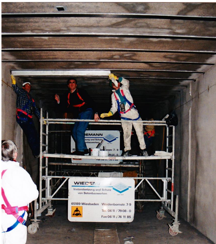
Bild 4: Einbaukontrolle der CFK-Lamellen durch Mitarbeiter der Firma Wiedemann
