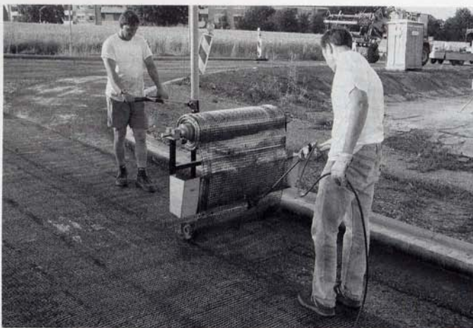
Bild 3: Handverlegung von S&P Glasphalt G
