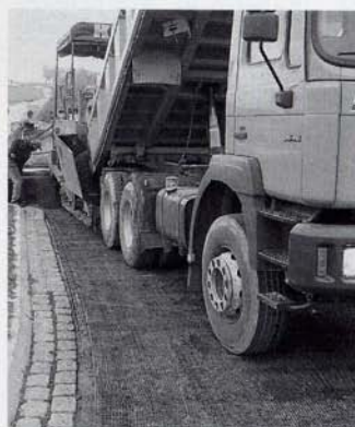
Bild 5: Verlegtes S&P Glasphalt G
