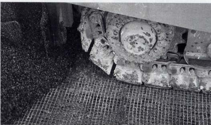
Bild 6: Einbau des Asphaltes auf S&P Glasphalt G
