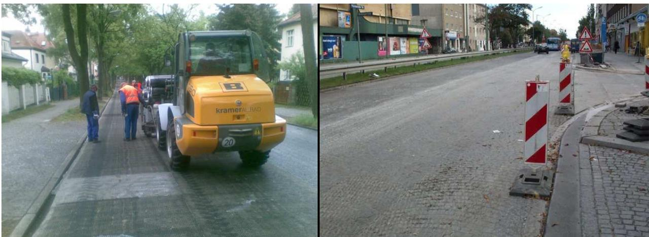
\*Überbau von Pflaster stellt eine Sonderbauweise dar. Die Steine müssen fest liegen! Ist Bewegung bei befahren des Pflasters nicht auszuschließen, kann das Schadensbild nur hinausgezögert oder vermindert werden. Oftmals ist eine Asphaltausgleichsschicht oder SAMI zu empfehlen.
