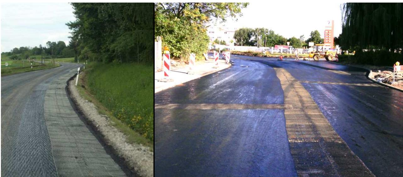
\*Die Konsolidierungsphase sollte abgeschlossen sein. Ist mit Setzungen der Straße/ des Unterbaus zu rechnen, kann das Schadensbild nur hinausgezögert oder vermindert werden.
