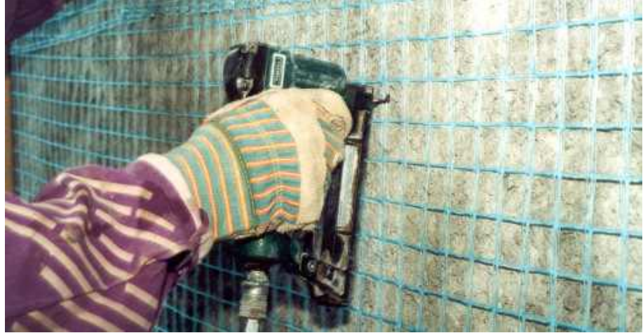
Bild 14: Fixierung mit Haftklammern
