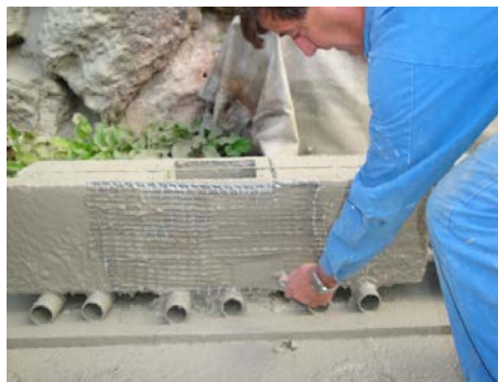
Bild 4: Applikation von Spritzmörtel und S&P ARMO-mesh L500
