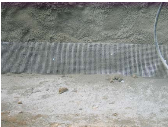
Bilder 15 / 16: lokale Verstärkung im Bereich der Ankerköpfe
