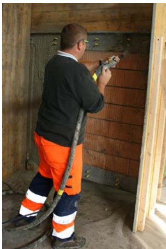
Bilder 24 / 25: Applikation des S&P ARMO-System
