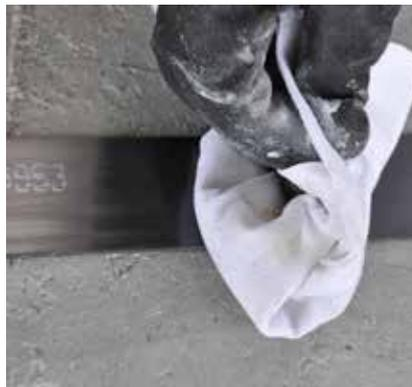
2 Reinigen der CFK Lamelle
