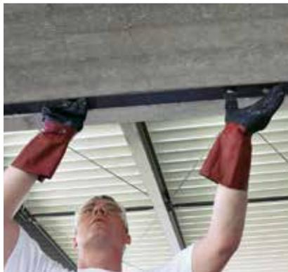
5 Montage/ Andrücken der Lamelle an das Bauteil
