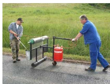
4a Händische Verlegung der Asphaltarmierung
