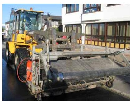
4b Maschinelle Verlegung der Asphaltarmierung
