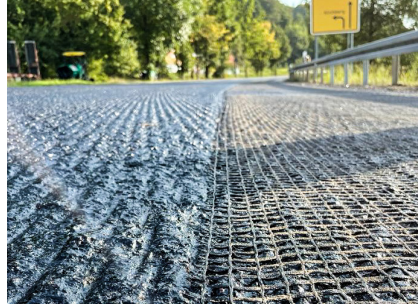
Gefräste Oberflächen
