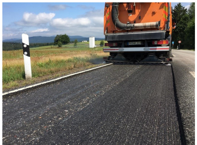
Reinigen der Oberfläche
