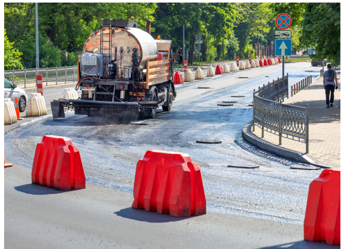
Anspritzen der Bitumenemulsion
