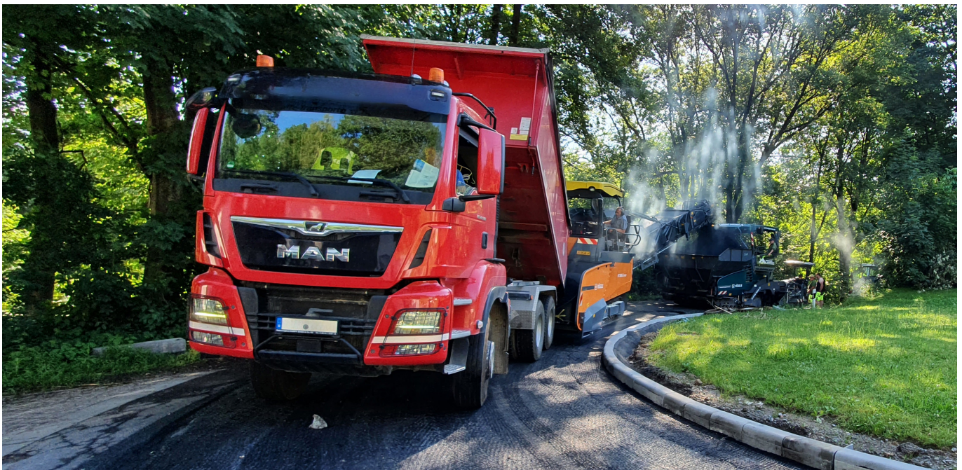
Fertiger und Transportfahrzeuge müssen vorsichtig fahren
