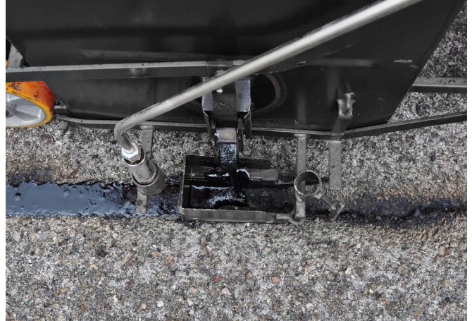
Rissverguss mit heißem Bitumen
