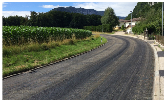
Beispiel für ein in einer Kurve verlegtes S&P Asphaltbewehrungsgitter
