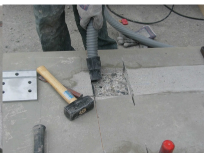
Entfernen des Betons im Bereich der Aussparung;
