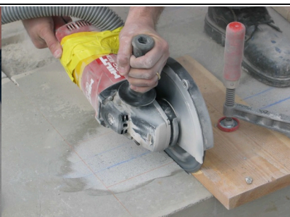
Frässchnitte an allen Seiten ausführen; an Stirnseite die Schnitte nicht überschneiden!
