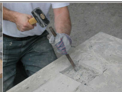
Entfernen des Betons im Bereich der Aussparung;
