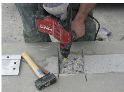
Bohren und versetzen des fischer Ankers; das Gewinde muss 40 mm überstehen
