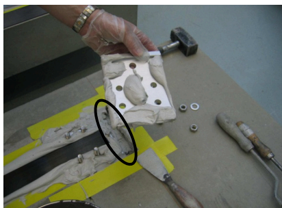
Der Klebstoff hinter der Grundplatte muss aus der Aussparung entfernt werden
