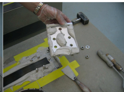
Auf die Deckplatte wird ebenfalls Klebstoff aufgetragen
